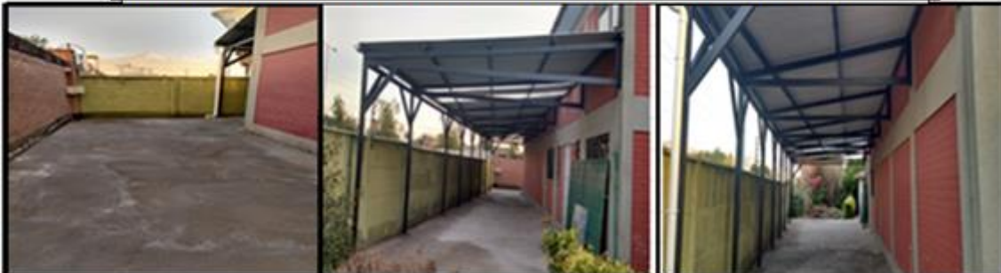
ACTUAL “SALA MULTIFUNCIONAL” CASA SCOUT – ESTADIO MARISTA
